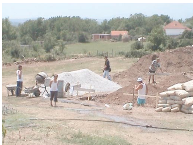
Почетак радова на изградњи нових темеља, Љуг, јул 2006. године
